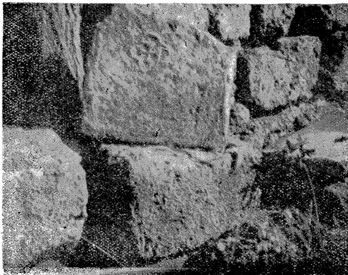
Сл. 7а. — Блокови од делкан бигор од јужниот ѕид на централниот кораб на црквата Св. Богородица во с. Вранишча. Меѓу ними е и една тула најдена во црквата
